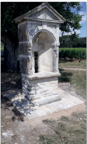
▲ Restauration de l'oratoire
